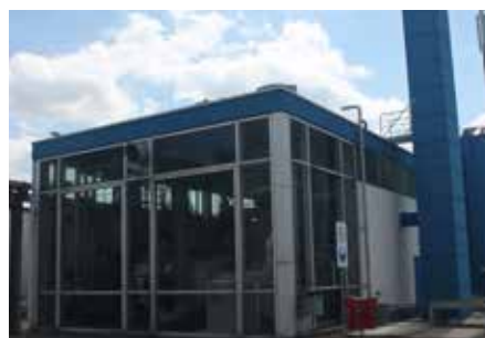
Dampfkesselhaus mit integrierter Abluftverbrennung und NOx-Reduzierung
