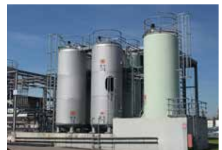
Tanklager für Rohstoffe
